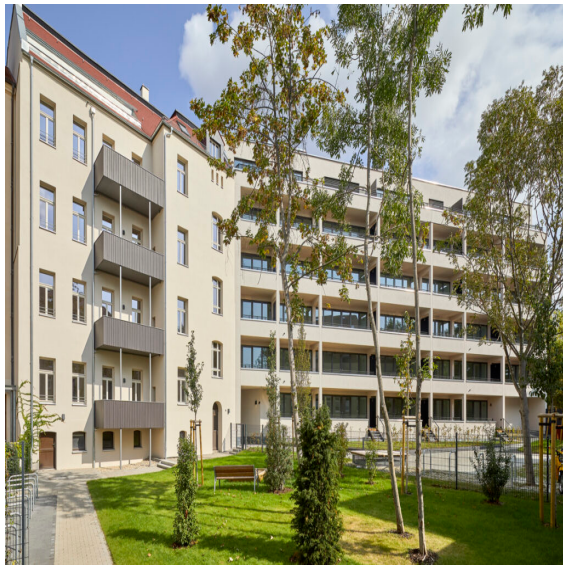
Neubau eines Wohnhauses mit Tiefgarage
